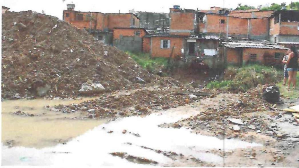
Esgoto a céu aberto.
