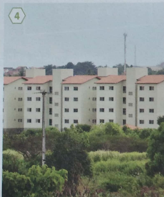
➤ Conjunto habitacional construído para famílias de baixa renda em Feira de Santana, estado da Bahia, 2016.
