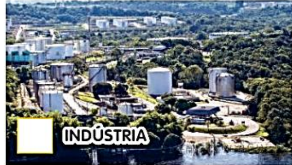
▶ Refinaria em Manaus, no estado do Amazonas, 2015.
