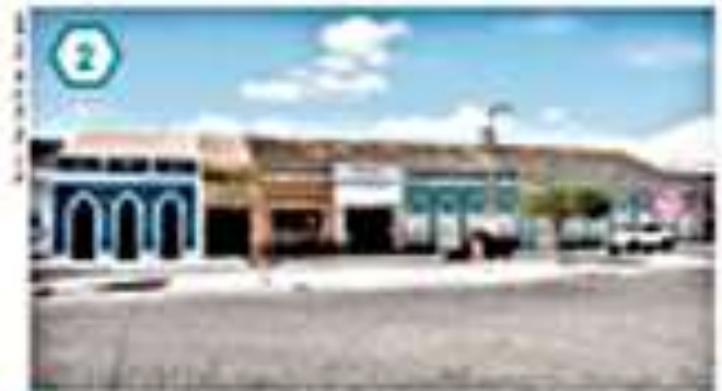
➤ Monteiro, no estado da Paraíba, 2016.
