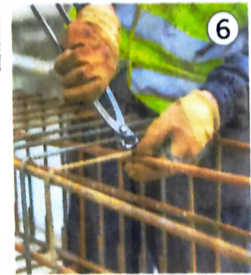
Operário trabalhando na construção civil.
