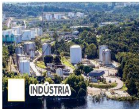
▶ Refinaria em Manaus, no estado do Amazonas, 2015.
