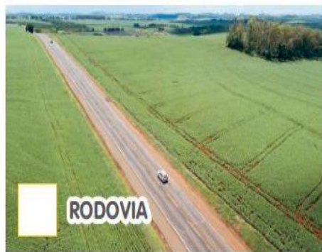
▶ Rodovia BR-369 em Cornélio Procópio, no estado do Paraná, 2016.
